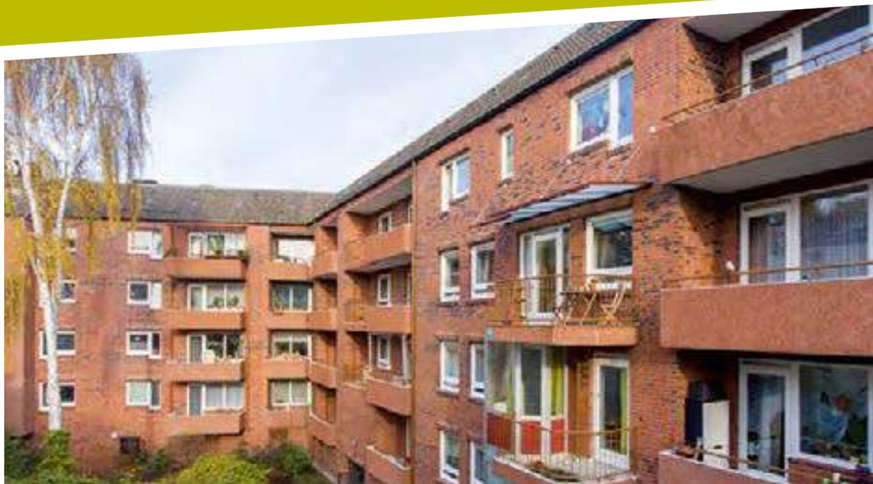
Im Zuge der Fassaden- und Balkon- sanierung erhielten die obersten Balkone eine Überdachung.
