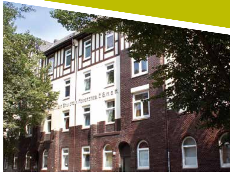
Fährstraße 79/81: Treppenhaussanierung in 2015
