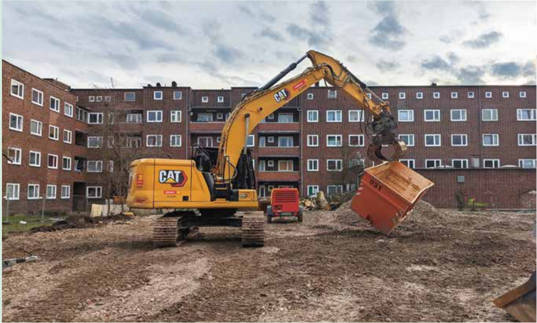
In der Mannesallee in Wilhelmsburg errichtet der BAUVEREIN einen Neubau mit 21 Wohnungen. Das angrenzende ehemalige Gemeindehaus wird zu einem Wohngebäude mit 12 Wohnungen umgebaut.
