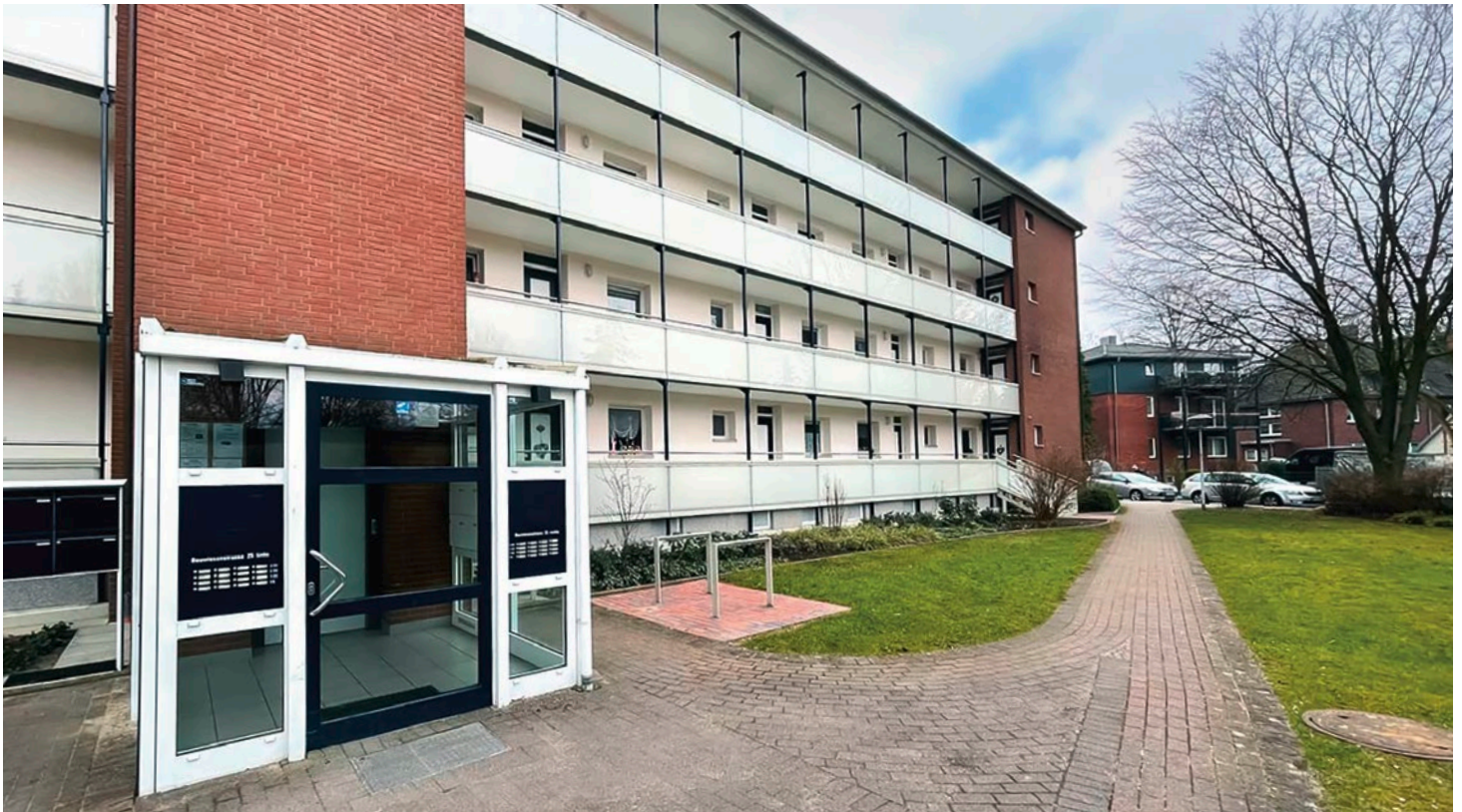
Bauwiesenstraße 25: Die Laubengänge erhielten neue Brüstungen aus Rauchglas.
