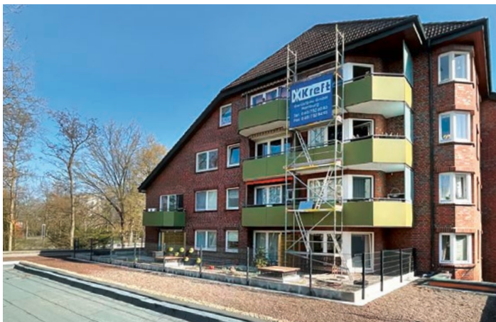
Ziegelerstraße 3: Terrassenumgestaltung auf den Dachflächen und neue Abdichtung für die Garagendächer
