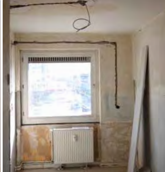
Bei größeren Wohnungsmodernisierungen werden die Bäder vollständig erneuert, die Heizkörper ausgetauscht und...
